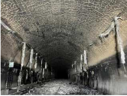
トンネル内部(全景)
