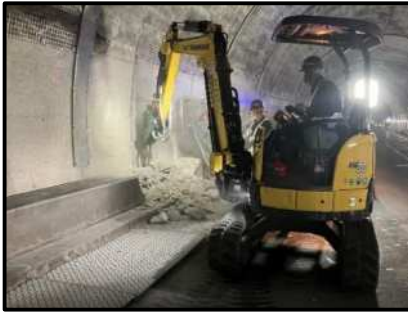
トンネル非常用設備(配水管等)撤去
